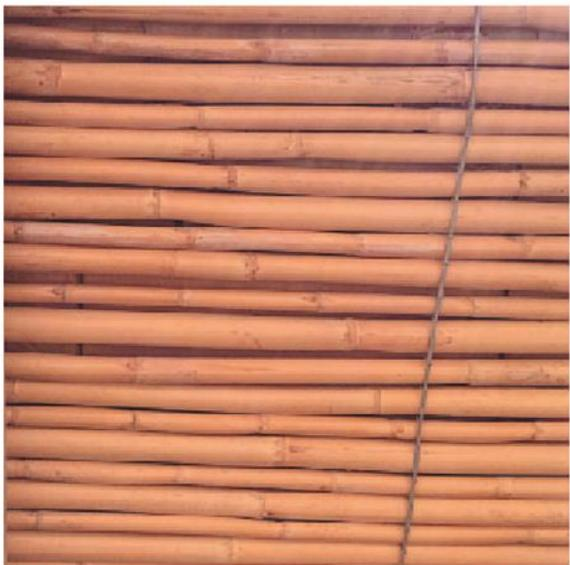
**CUBIERTA DE CAÑA, colocadas sobre tirantes de madera, amarradas con alambre**
